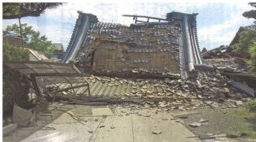
★全壊した益城町の専寿寺の本堂
